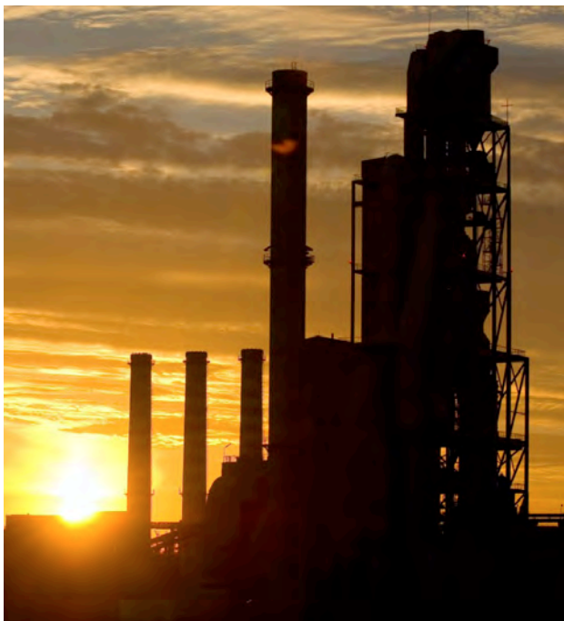
Planta de Cemento Chelm, Polonia
