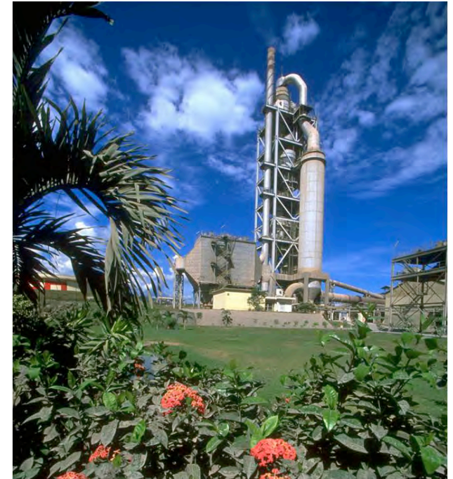
Planta de Cemento APO, Filipinas
